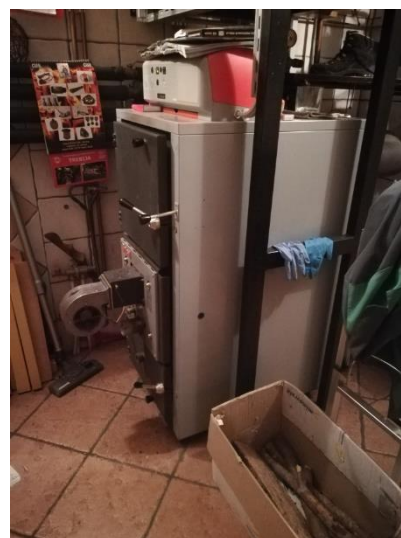
Slika 9: ventilacijska peč na drva
